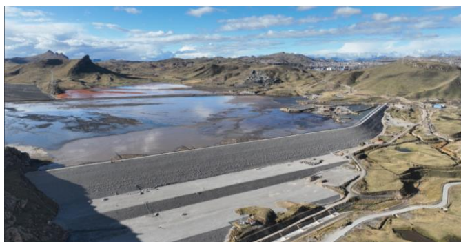
Figura 1: Vista del depósito de relaves Ocroyoc de la unidad minera de Cerro
